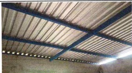
FOTO 1: SUSTITUCION DE LAMINA TROQUELADA ALUZINC CALIBRE 26
