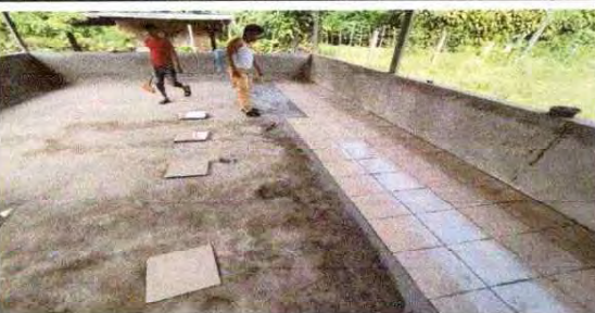
FOTO 18: SUSTITUCION DE PISO CEMENTO LIQUIDO POR PISO CERAMICO
