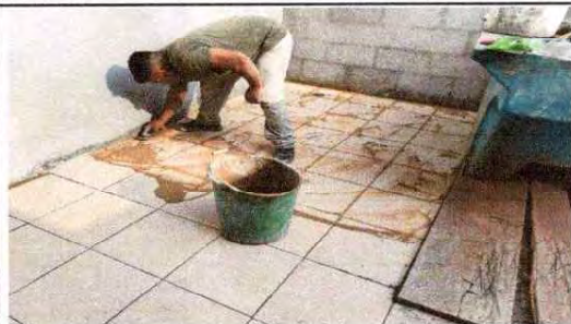
FOTO 7: SUSTITUCION DE PISO LIQUIDO POR PISO CERAMICO
