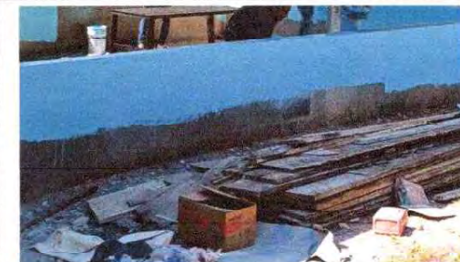
FOTO 18: PINTURA EN MUROS EXTERIORES
