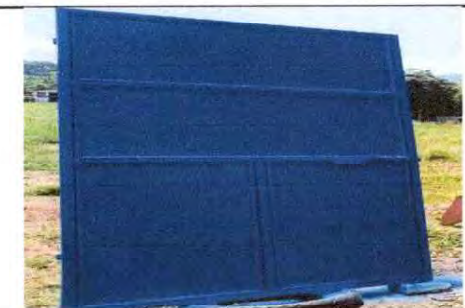
FOTO 15: FABRICACION E INSTALACION DE PUERTAS DE METAL EN MODULO
