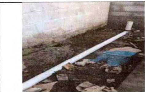
FOTO 11: SUSTITUCION DE TUBERIA PVC LINEA PRINCIPAL AGUAS NEGRAS
