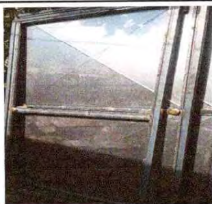
FOTO 3: FABRICACION E INSTALACION DE PUERTAS DE METAL EN MODULO
