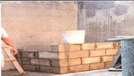
FOTO 13: SUSTITUCION DE ESTUFA RURAL (COMPLETA) INCLUYE CHIMENEA Y PLANCHA DE METAL
