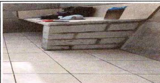
FOTO 10: SUSTITUCION DE AZULEJO
