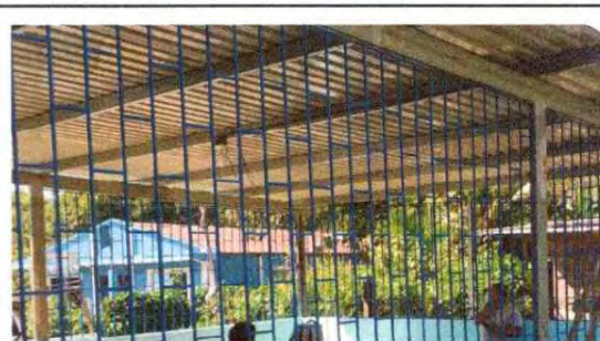
FOTO 16: FABRICACION E INSTALACION DE VENTANA-BALCON DE METAL
