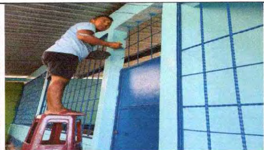
FOTO 9: PINTURA EN MUROS EXTERIORES E INTERIORES
