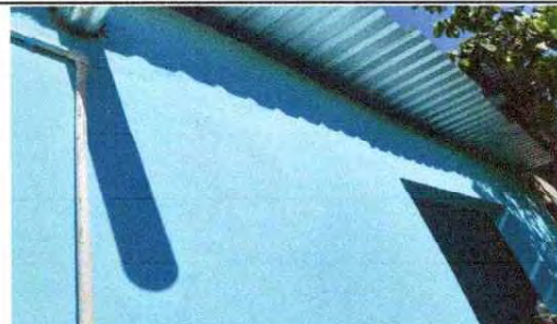
FOTO 8: SUSTITUCION DE CANAL DE METAL Y SUSTITUCION DE BAJADA DE AGUA PLUVIAL DE METAL POR TUBO PVC 3
